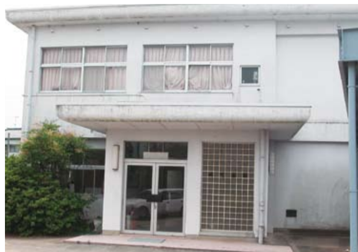
同窓会館全景
