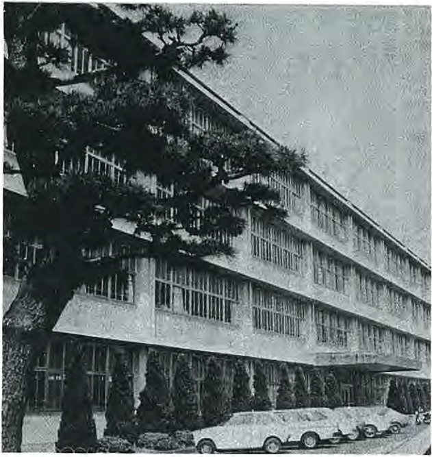
藤枝東高現校舎正面
